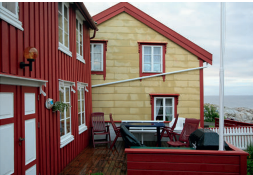
Fra ca 1952 ble det produsert farget veggpanel ved Norsk Eternitt Fabrikk. Senere (1960-tallet) kom "Super-eternitt", som hadde ekstra hard overflate. Dette bildet er fra Grip. Foto: Birger Lindstad©Riksantikvaren.
