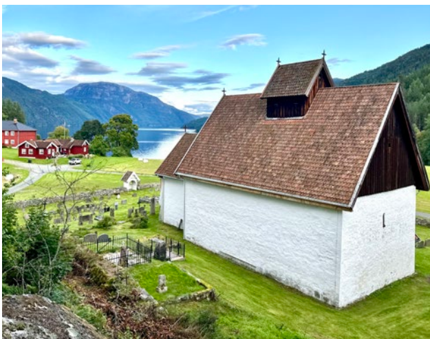
Kviteseid gamle kirke er fra år 1150 og ligger i Telemark fylke. Vernestatus: fredet.
