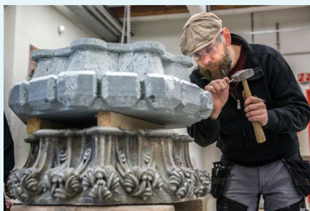
Bygghytta ved Nidaros Domkirkes Restaureringsarbeider har plass på UNESCOs liste over gode vernepraksiser for sin unike kompetanse innen tradisjonelle håndverk. Her er steinhugger Espen i aksjon.
