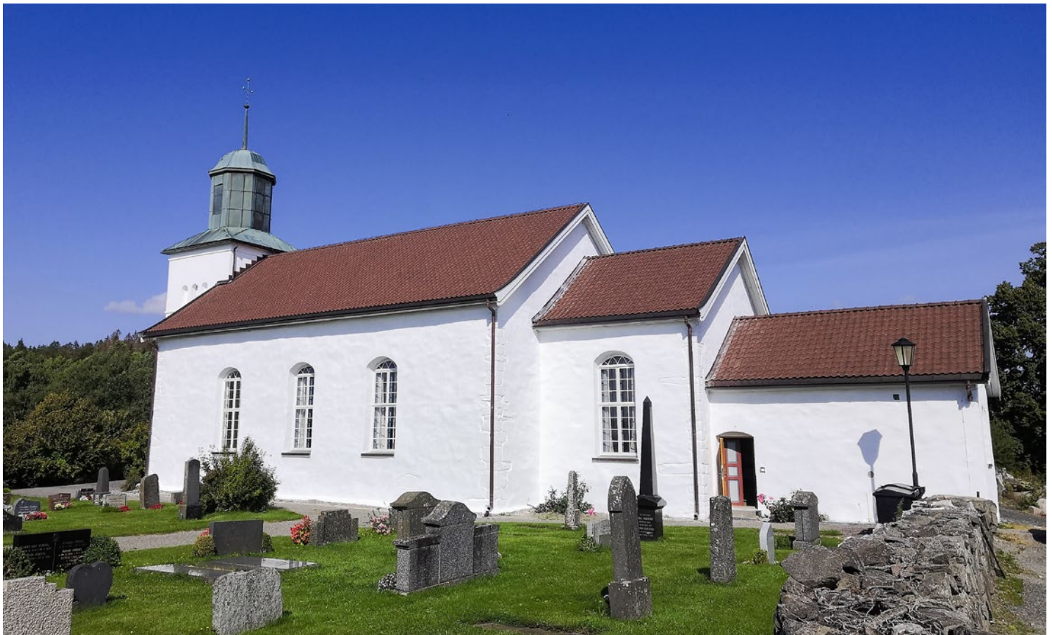
Botne kirke ferdig istandsatt med kalk. Botne kirke er fra år 1200 og ligger i Vestfold fylke. Vernestatus: fredet. Foto: Geir Magnussen.
